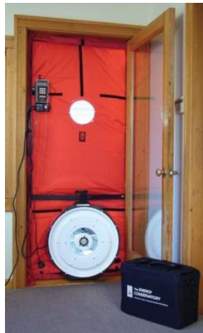
Uitvoeren van een blowerdoortest
