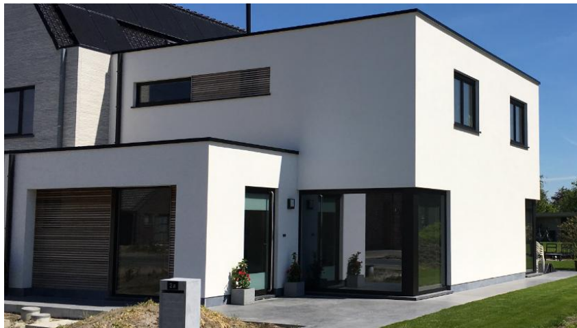
Gevelafwerking met gevelbepleistering en arduinplint
