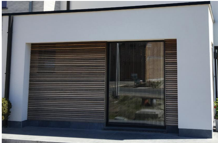
Gevelafwerking met houten lattenwerk in Padoek
