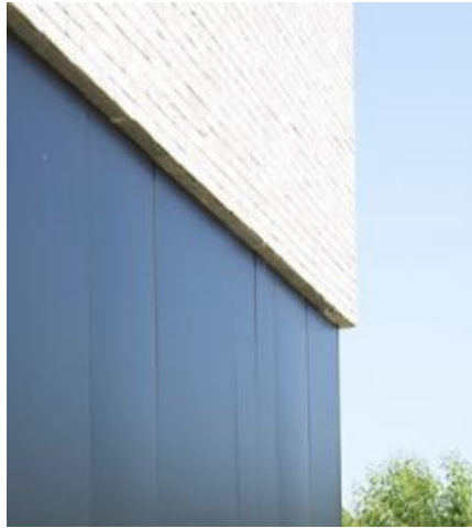
Foto : Gevelafwerking met ALU gevelbekleding
