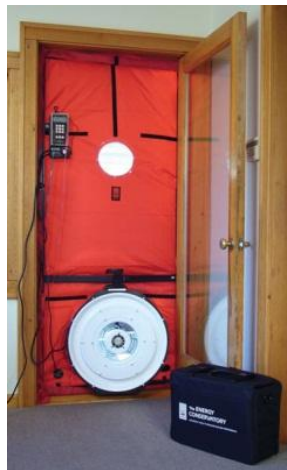
Foto : Uitvoeren van een blowerdoortest
