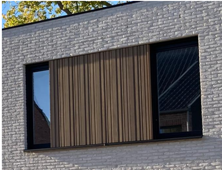
Foto : Gevelafwerking met houten gevelbekleding in geprofileerde "Thermo Ayous" – planchetten
