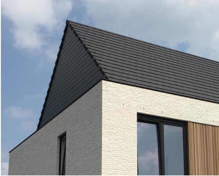
Foto : Platte dakpan type Nueva Antraciet met van Koramic met gevellen type Alterna donkergrijs voor de topgevels
