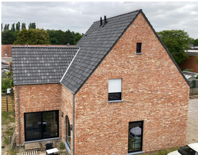
Foto : Dakbedekking bestaande uit de Brugse dakpan van Monier kleur blauwgrijs
