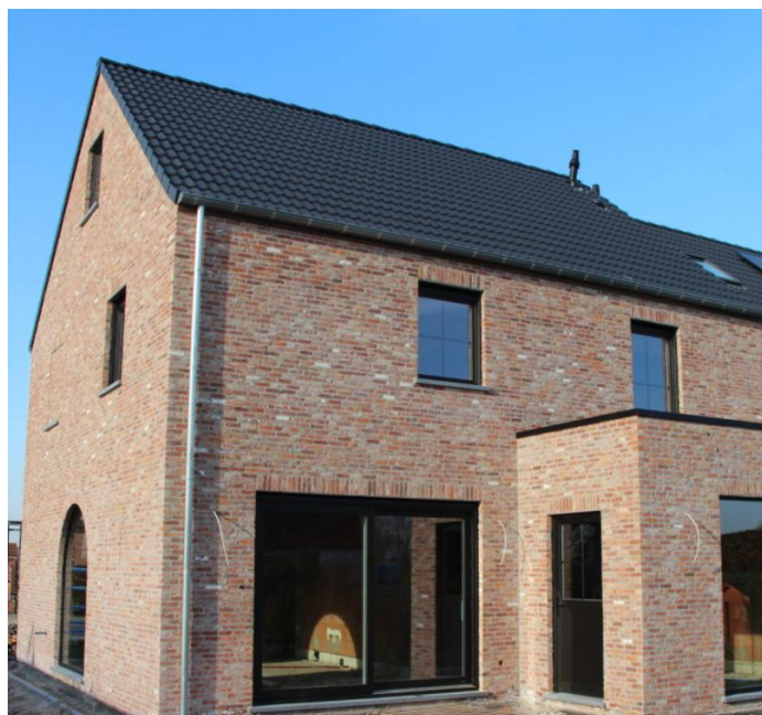
Foto : Gevelsteen type Beerse Klinker Rijnformaat Gemetst In wildverband
