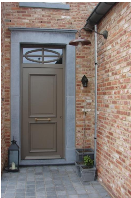
Foto : Gevelsteen type Beerse Klinker Waalformaat gemetst in Wildverband
