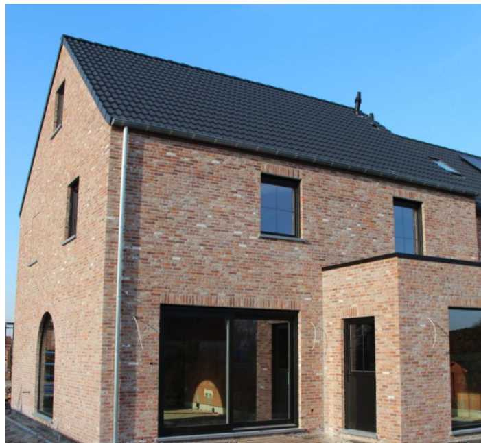
Foto : Gevelsteen type Beerse Klinker Rijnformaat Gemetst In wildverband
