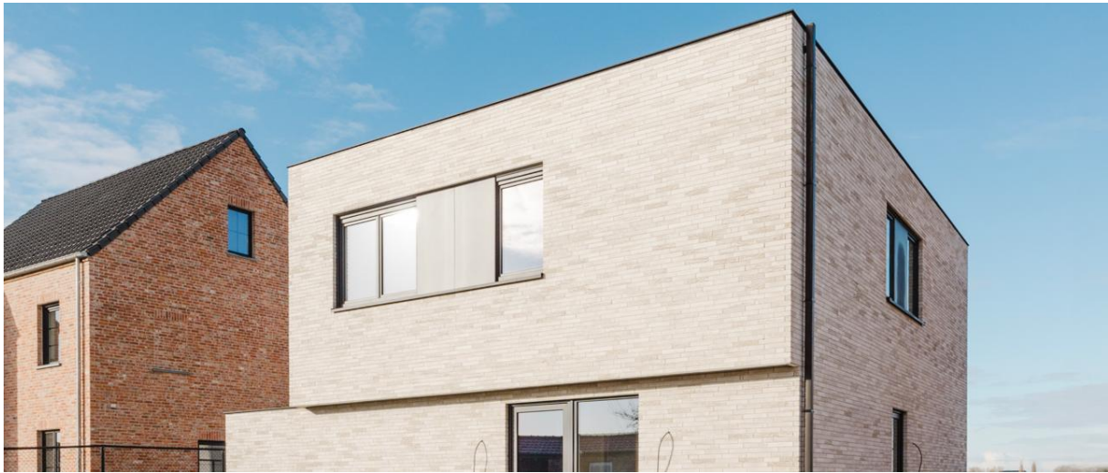
Foto : ALU – plooiwerk tussen twee ramen
